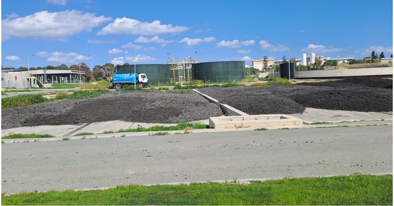
Εικόνα 24:Υπαίθριος χώρος προσωρινής αποθήκευσης αποξηραμένης βιολογικής λάσπης. Βόρεια άποψη του κεντρικό σημείου του τεμαχίου ανάπτυξης.
