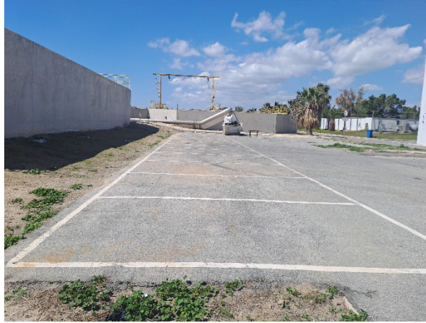
Εικόνα 17: Χώρος κατασκευής επιπρόσθετης αναερόβιας δεξαμενής
