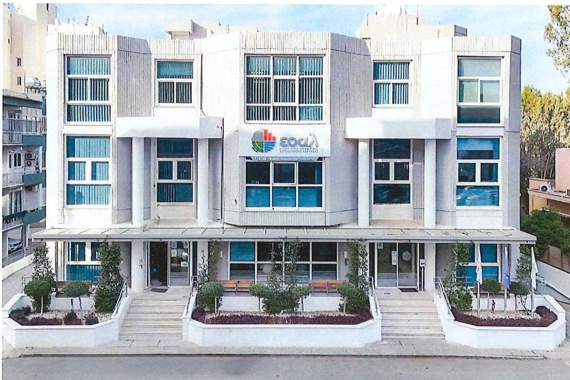
Εικόνα 1: Φωτογραφία του Κτιρίου Διοίκησης του Επαρχιακού Οργανισμού Αυτοδιοίκησης Λάρνακας (Πρώην Συμβούλιο Υδατοπρομήθειας Λάρνακας (ΣΥΛ))
