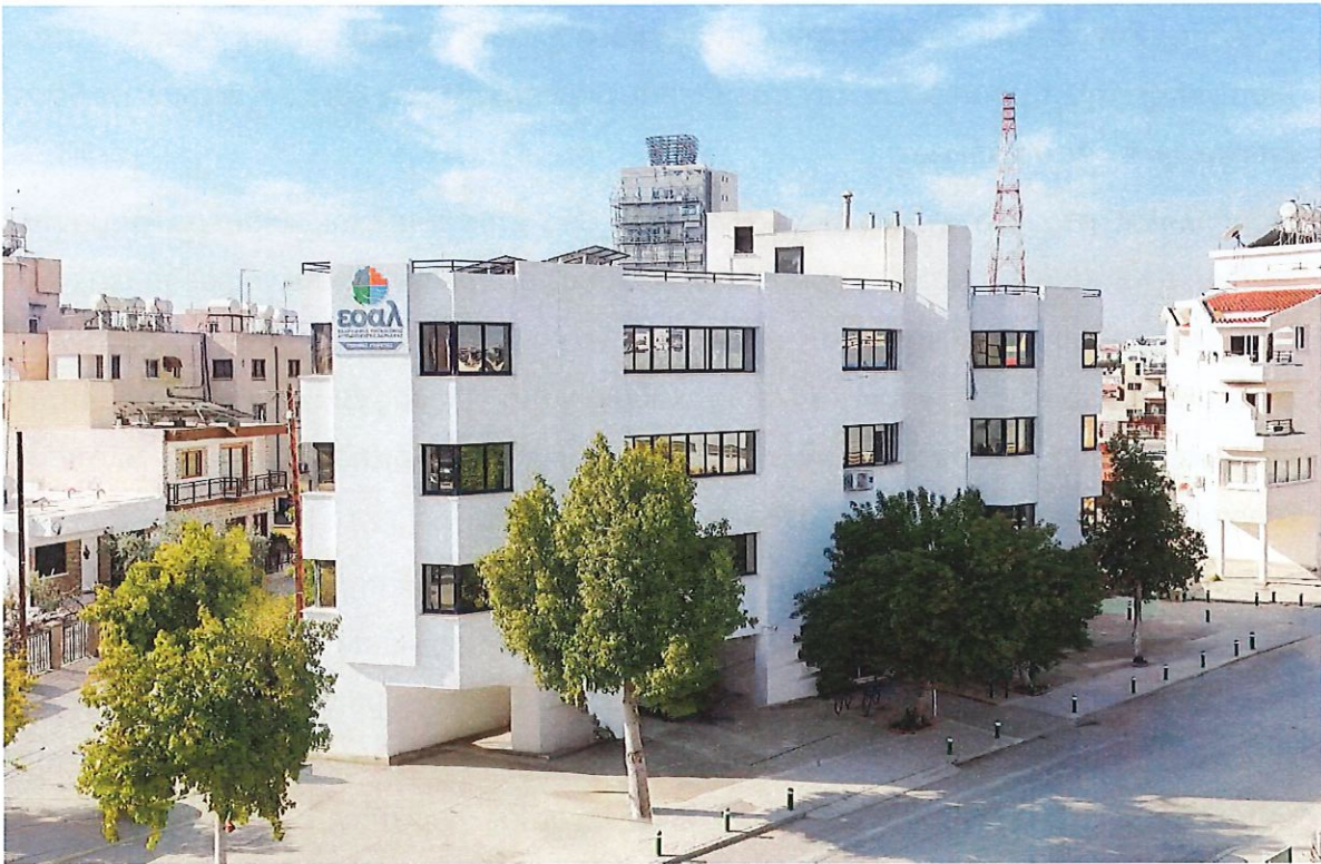
Εικόνα 2: Φωτογραφία κτιρίου Τεχνικών Υπηρεσιών ΕΟΑΛ (Κτίριο Πρώην Συμβουλίου Αποχέτευσης Λάρνακας (ΣΑΛ))
